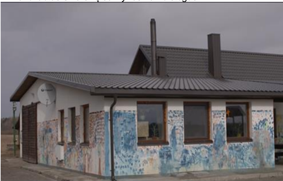
Renovuotas Sikorskių šeimynos namo stogas.
